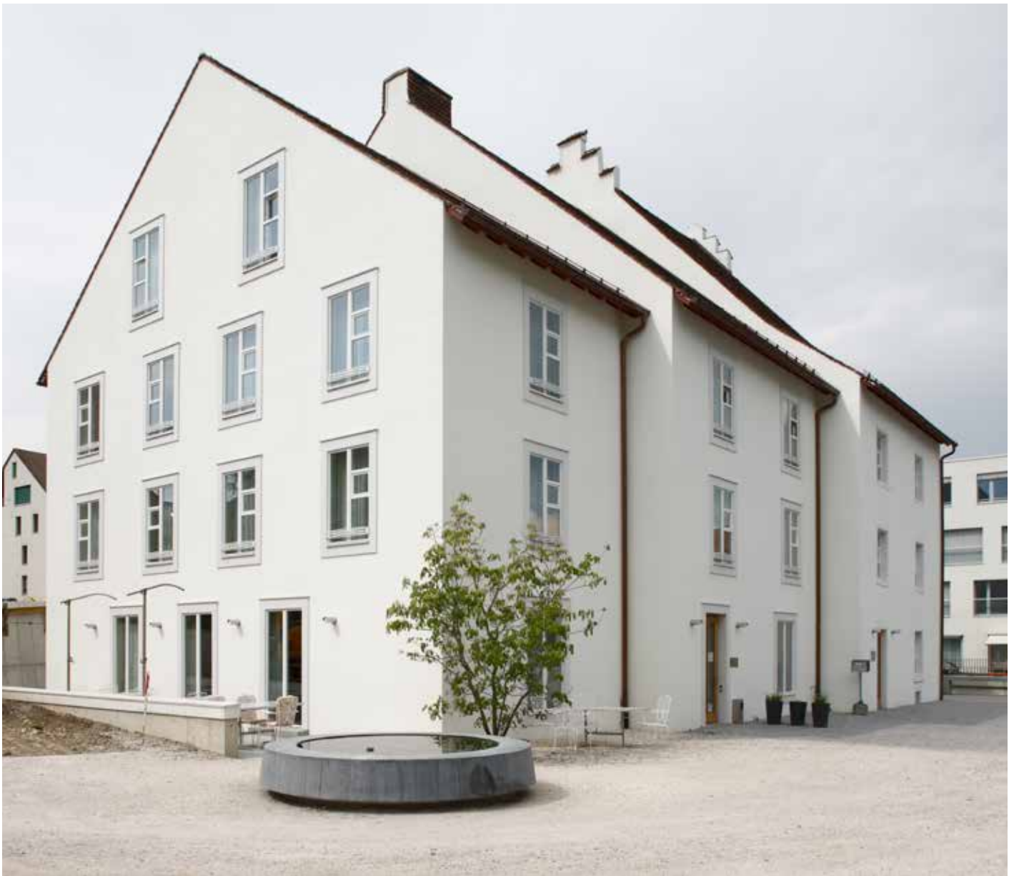
Neu und Bestand erscheinen als Einheit: Buol & Zünd Architekten BSA, Imhofhaus, Binningen, Schweiz 2008, Foto: Michael Fritschi und Christian Flierl
