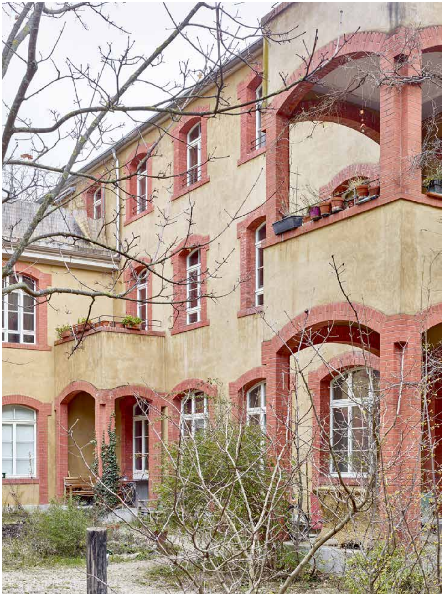
Buol & Zünd Architekten BSA, Umbau einer Fabrik an der Oetlingerstrasse, Basel, Schweiz 2005, Foto: Philip Heckhausen, Zürich
