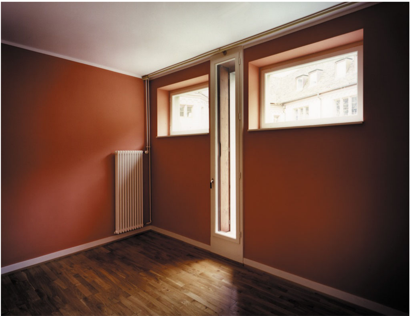
An der Stelle der ehemaligen Zellenwand befindet sich nun ein raumhohes Fenster. ©Georg Aerni
