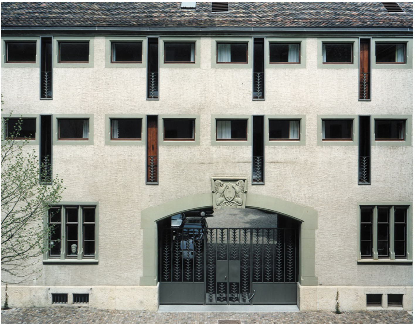
Das Geländer aus Gusseisenteilen wurde eigens für das Projekt gestaltet ©Georg Aerni
