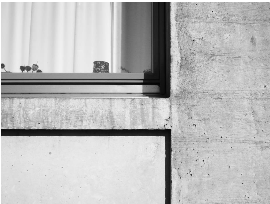
Fensterdetail: Fein abgestimmtes Schalungsbild, präzise gefügtes Fenster
