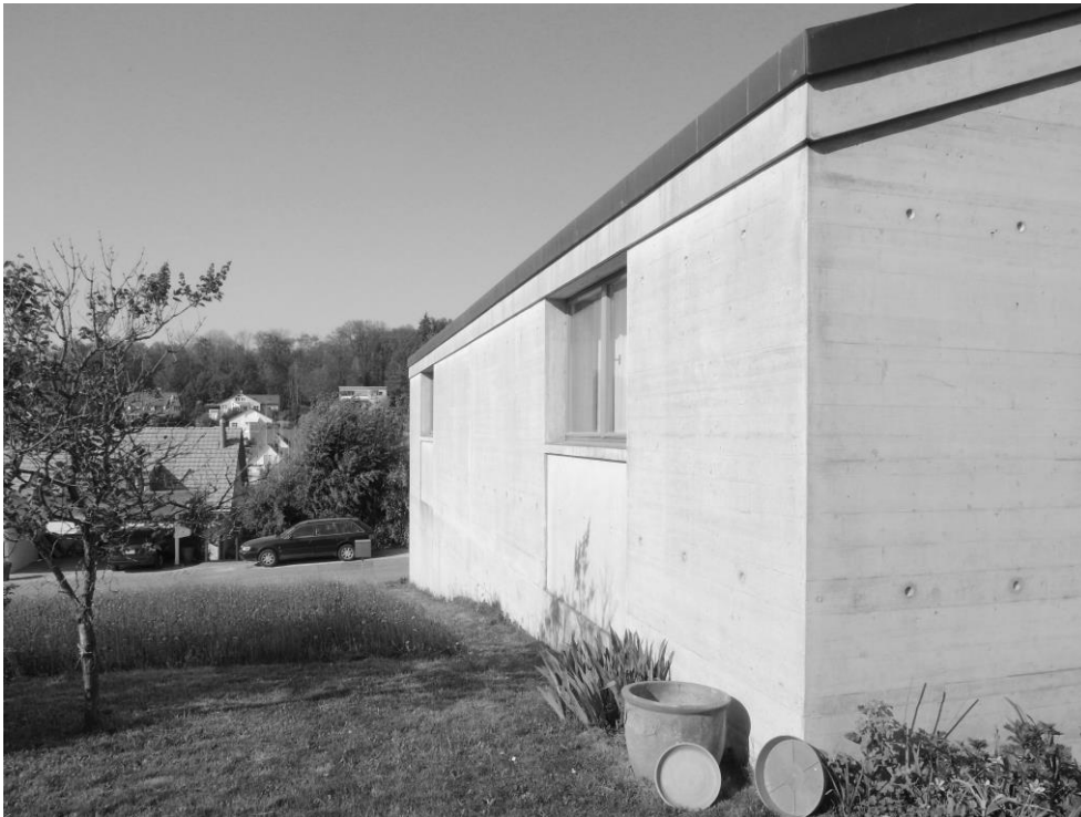
Westfassade: Brüstungsfelder unter den Fensteröffnungen, von Kranzgesims hervorgehobener Übergang zum Dachrand
