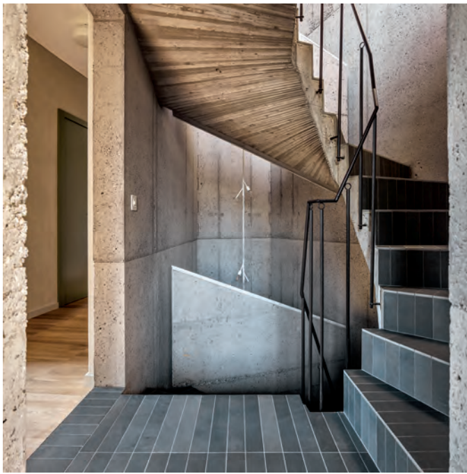
Höhlenartig: einer von zwei Treppenkernen aus rohem Beton.
