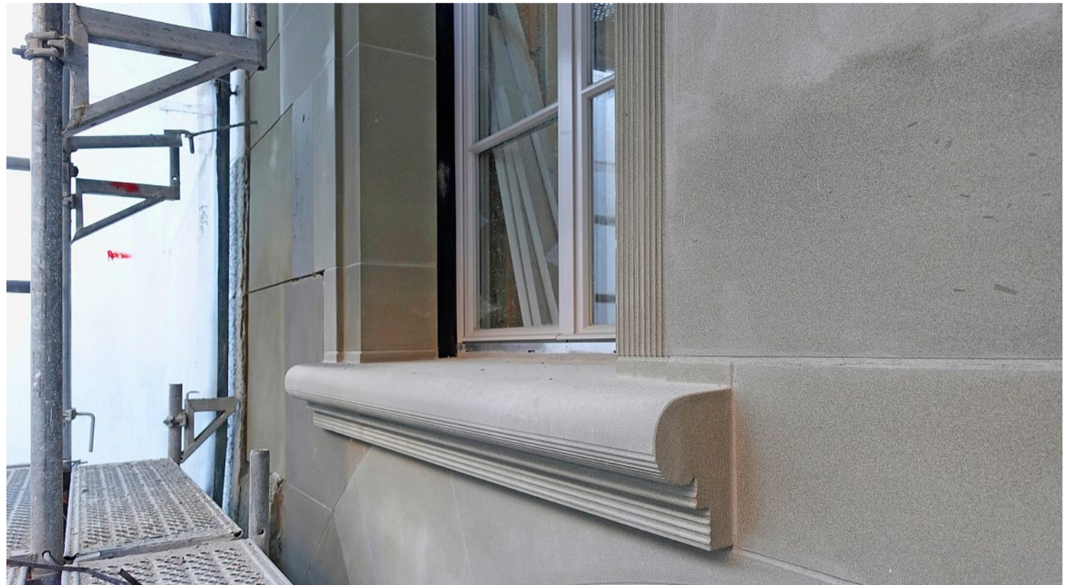
Die rillenartigen Arbeitsspuren im Sandstein werden nicht weggeschliffen, sondern als dekoratives Finish stehen gelassen. Foto: zvg
