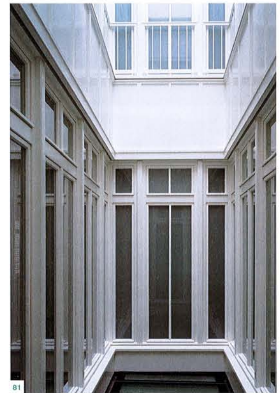
Blick in den Lichtthof. Im Erdgeschoss wird der Lichtthof zum Oberlicht.
