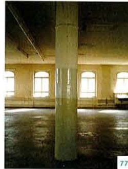
Vorgefundener Zustand als «Rohbau»
